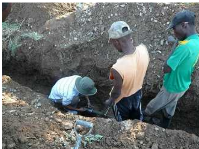
埋設給水管緊急補修
