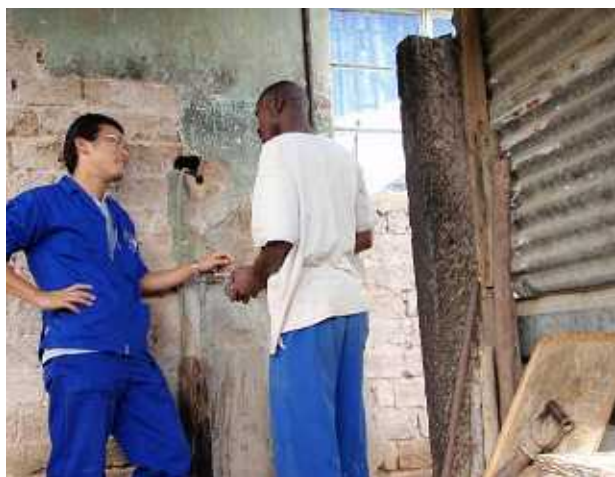
水道メーター取替え
